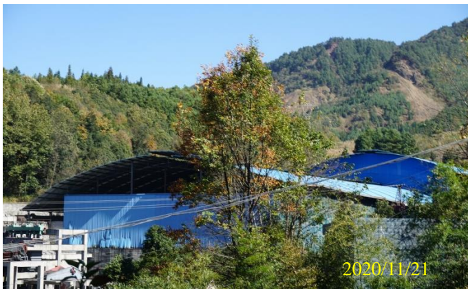
二期工程东面环境现状
