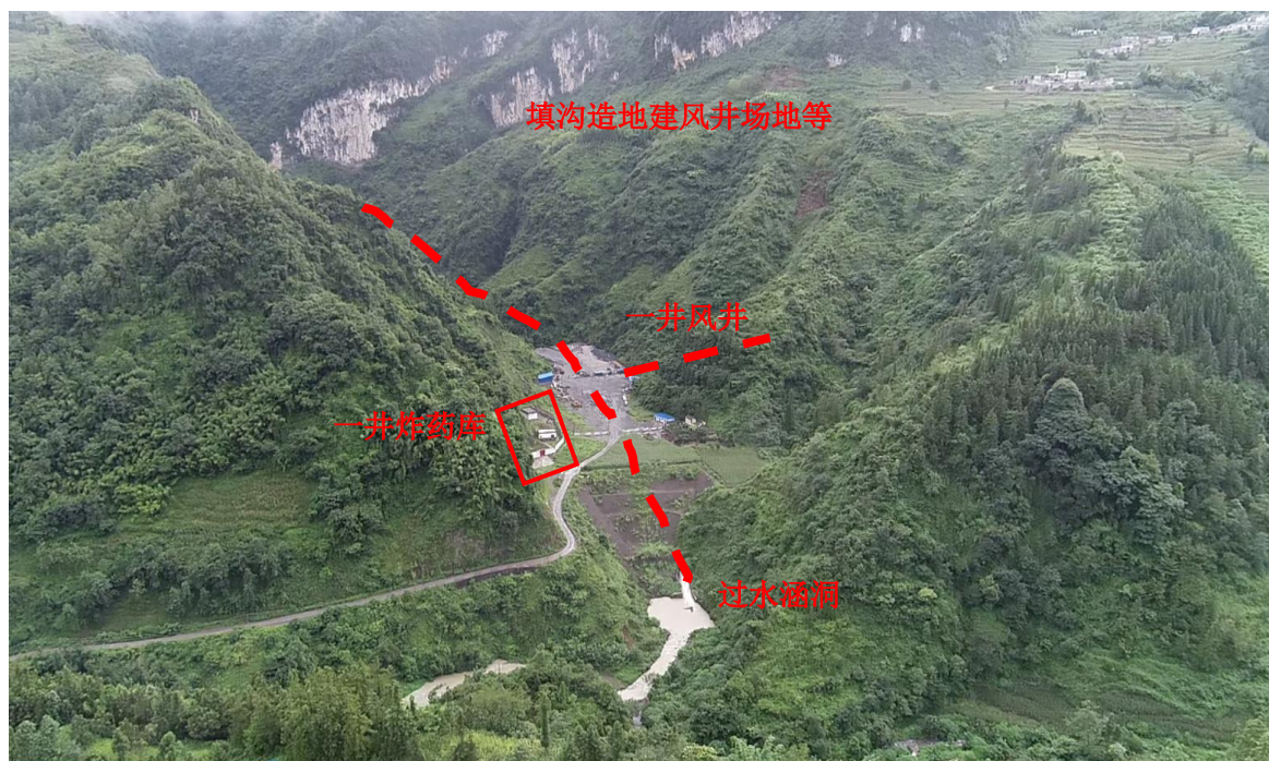
图2.2-5 拟利用的填沟造地场地现状情况
