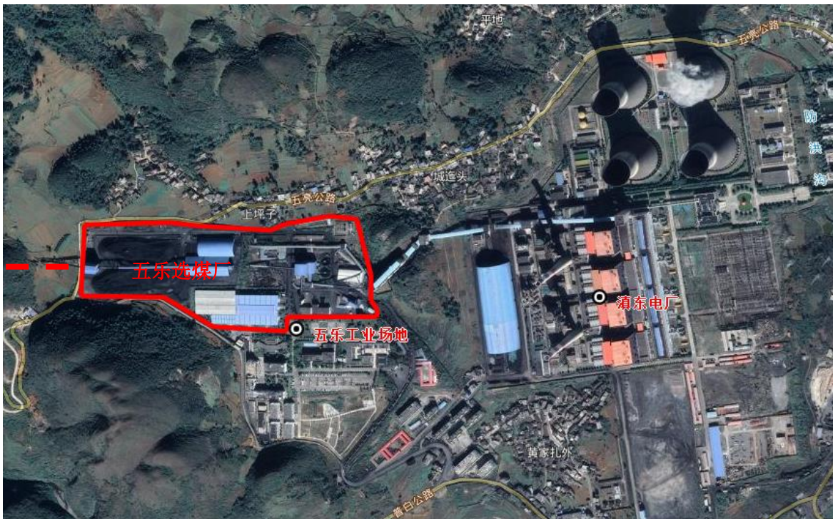
图2.2-3 已建五乐选煤厂（五乐工业场地内北侧）现状情况
