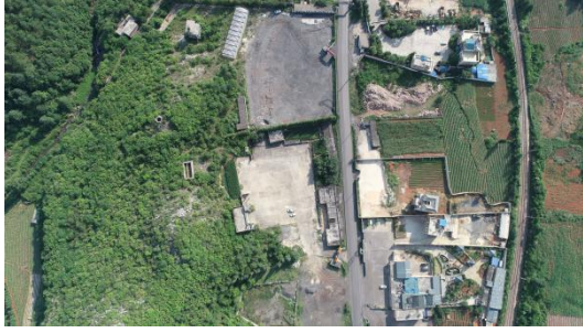
项目厂区整体照片
