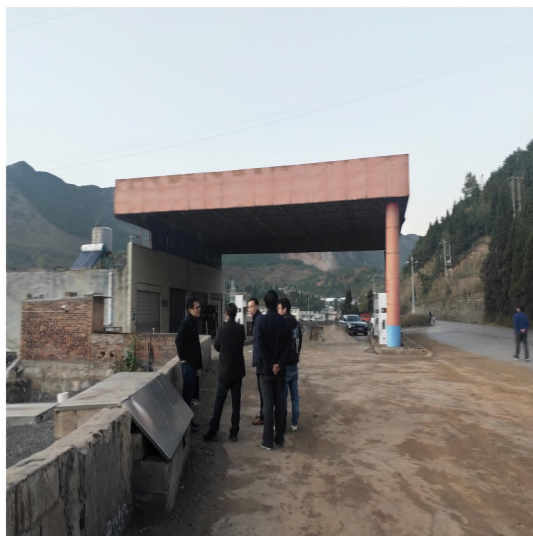
原加油站整体
