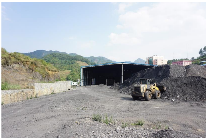
项目现状及南面环境现状
