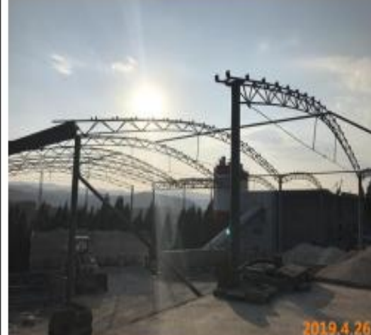
照片 4: 在建原料堆场 (大棚封闭)
